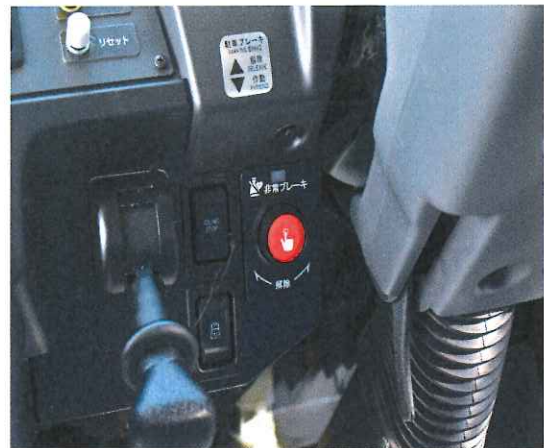
運転士操作用非常ボタン
